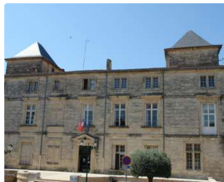
Début des travaux de rénovation de l'hôtel de ville
